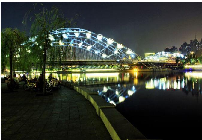
奉化桥，也叫直沽桥！海河东路划线区域停车暂时不收费！奉化桥 27 道拱每三道形成一组跨，夹在三道拱之间的就是花瓣状的钢结构，整座桥共有 68 片“花瓣”，每片“花瓣”由两个钢制“三角形”组成，工程人员将它们戏称为“钢锅盖”。由于设计独特且技术含量高，奉化桥
